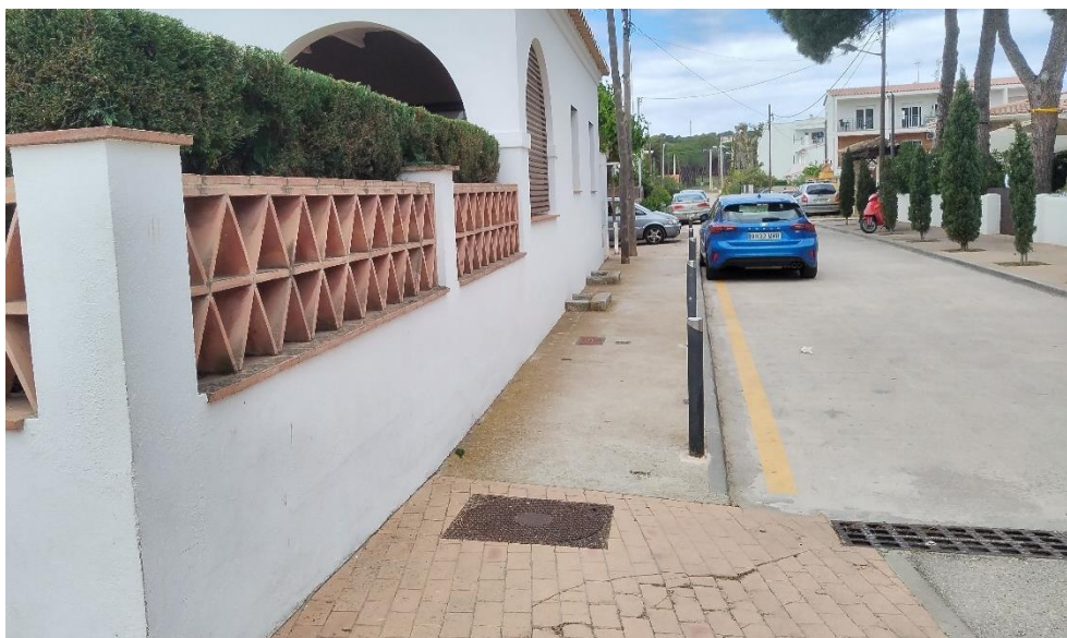
ÚLTIM TRAM DEL CARRER DELS TERMES
