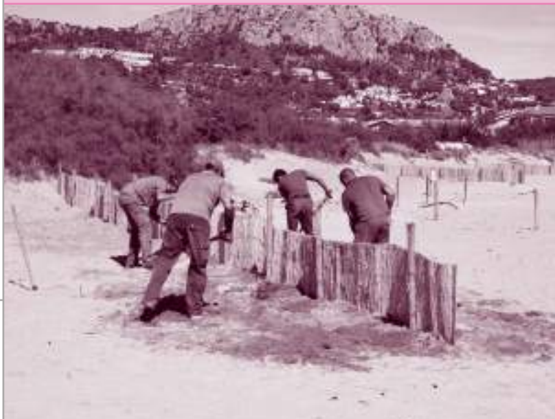
▼ Treballs de restauració del front dunar. Foto: Ajuntament de Torroella de Montgrí.
